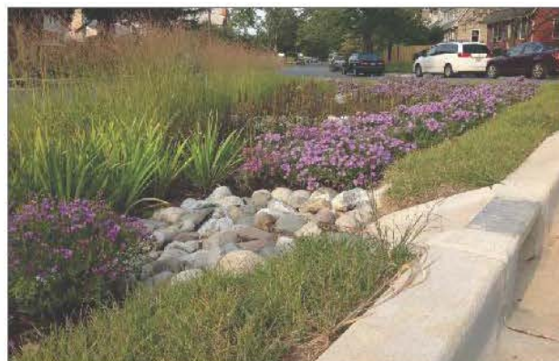
Dagvattenplantering mellan parkeringsytor.
